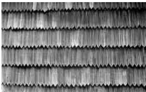
Văgaș, 1984 – învelitoarea de șindrilă a bisericii de lemn ortodoxe
