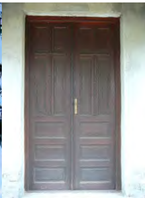
Accesul de pe fațada sudică
